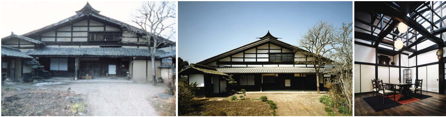
左は、築300年の古民家・草間邸の再生前外観。中は、再生後の外観（撮影：秋山実）。右は、再生後の内部の応接室（撮影：秋山実） （画像提供：降幡建築設計事務所）
